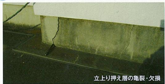
立上り押え層の亀裂・欠損
